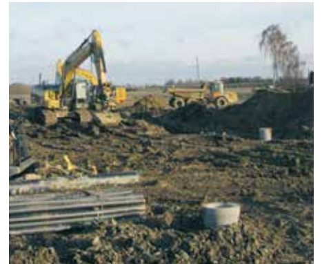
Stora jordmassor har schaktats runt i höst, dagvattendammarna anlagts och va-ledningar lagts ned i jorden. Till våren börjar villor och radhus byggas på nya Vikhemsområdet.
