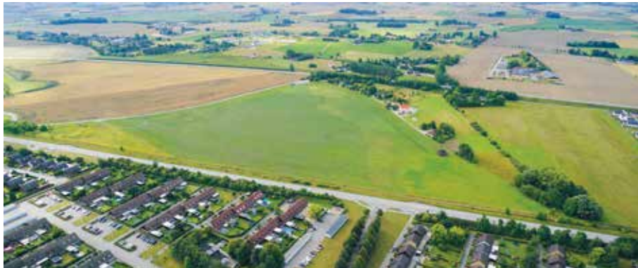
Vikhem är det nya bostadsområde som anläggs i den gröna triangeln norr om Kronoslättsvägen. Bilden togs innan markarbetena inleddes i höstas.
